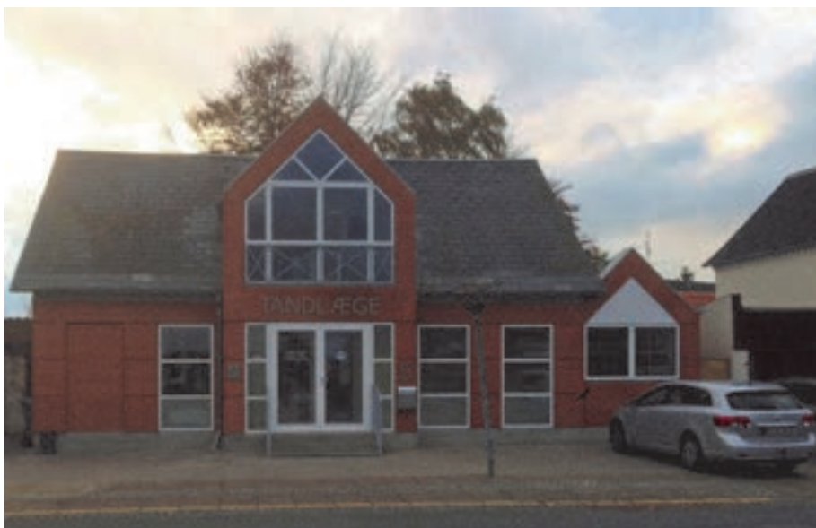
Tandlægenes flotte hus har gennemgået større renovering. Et resultat af projekt byfornyelse
