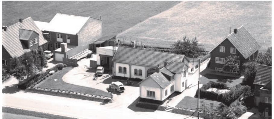
Kværndrup Andels-elektricitetsværk, 1959. SJ Lufffoto
