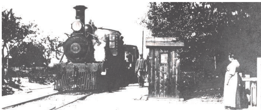
Ledvogtersken i arbejde ved Nyborg-Bøjden landevejen i Kværndrup (A8), omkring 1920. Foto: Lokalthistorisk Arkiv.
